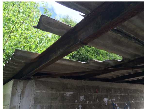
Déclaré - JR6 : Garages > Passage - Plaque - AC1- (Présence d'amiante)
