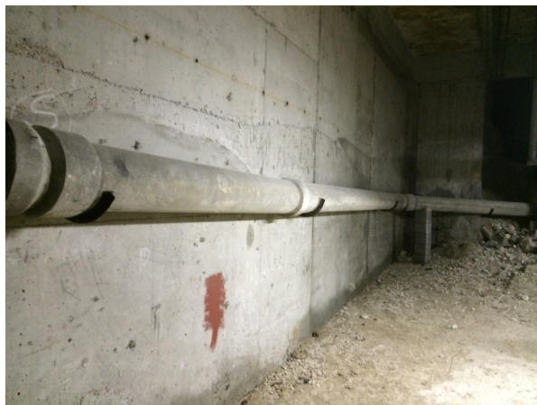
Déclaré - JR1 : Administration > Vide sanitaire - Conduit - EP- (Présence d'amiante)
